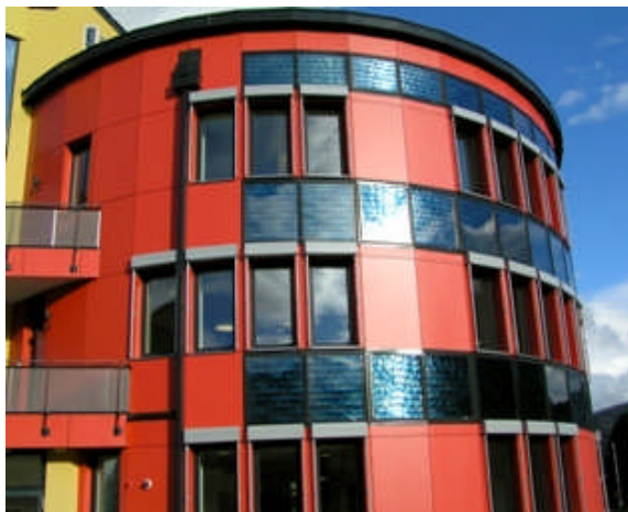
Fassade mit thermischen Kollektoren
