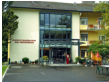
Contracting-Beispiel Landespflegezentrum Bad Radkersburg: Der Wärmeverbrauch wurde um rund 35 Prozent auf etwa 850 MWh reduziert
