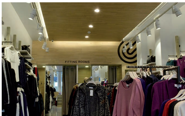
LED basierte Beleuchtung mit Energieeffizienz 2112 Watt
