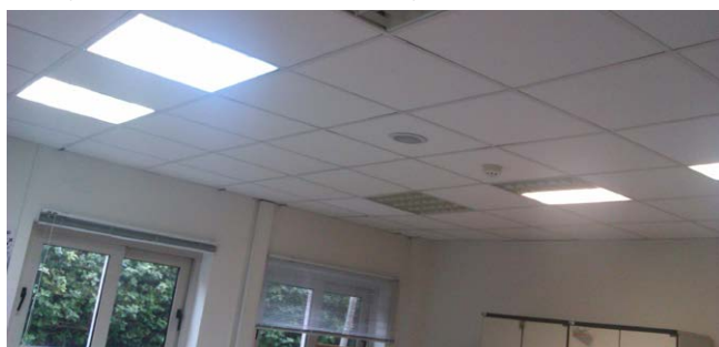
Beleuchtungseinbauten mit Leuchtstofflampen VOR der Umsetzung
