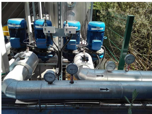
Pumpen mit variabler Geschwindigkeitssteuerung
