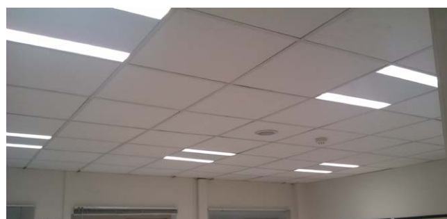
Beleuchtungseinbauten mit LED-Lampen NACH der Umsetzung
