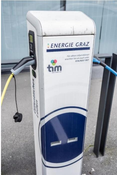
Abbildung 5.1-1: Öffentliche Ladestation 22 kW (Quelle: Energie Graz)
